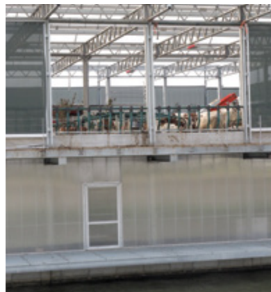
Budynek ma trzy poziomy, podwodny fundament stanowią trzy betonowe pontony, na których wzniesiono dwie kondygnacje. Tuż nad wodą mieści się zaplecze do przerobu mleka i przygotowania pasz, najwyższą kondygnację zajmują krowy
