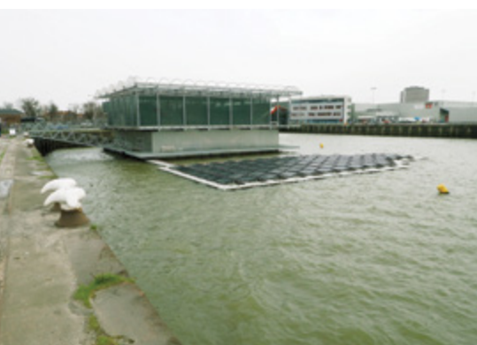
Pływające ogniwa fotowoltaiczne w 40% pokrywają zapotrzebowanie farmy na energię elektryczną
