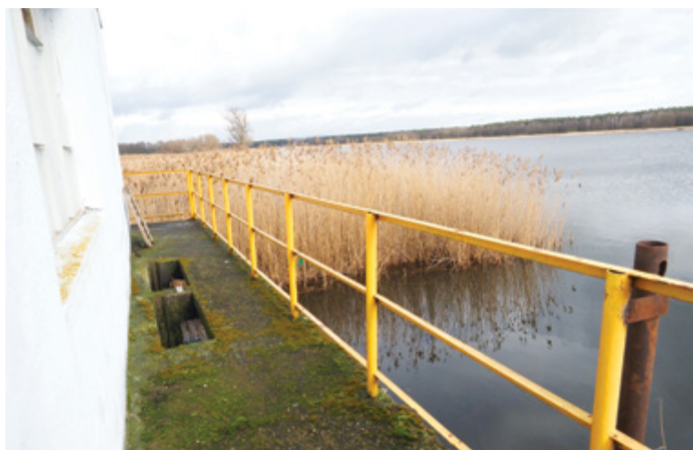
Ujęcie wody z Jeziora Jezierzyskiego, wchodzącego w skład zbiornika retencyjnego Wonieść
