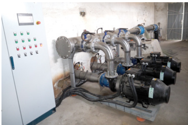
Wodę do systemu pięciu deszczowni centralnych tłoczą trzy pompy, każda o mocy 45 kW
